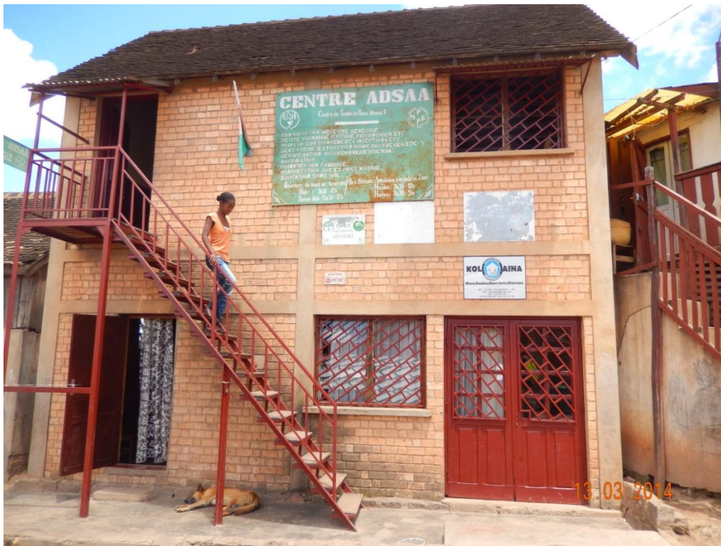
Façade du Centre de santé de l'ADSAA
